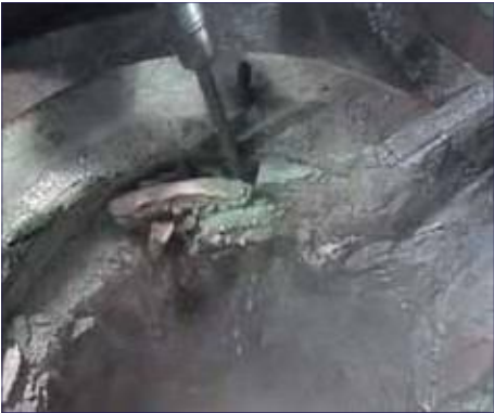
Верхнее кольцо тигля удаляется пневматическим молотком
