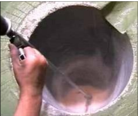
Заполните монтажное отверстие специальной смесью и виброуплотните
